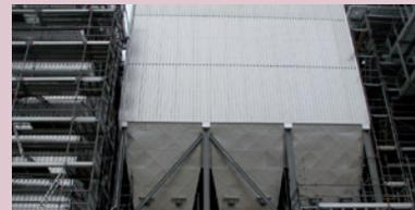
Trockene Abgasreinigung mit Reaktor, Gewebefilter und Entstickung.
