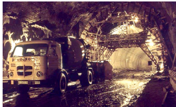
La Rovira tunnel. Barcelona.
