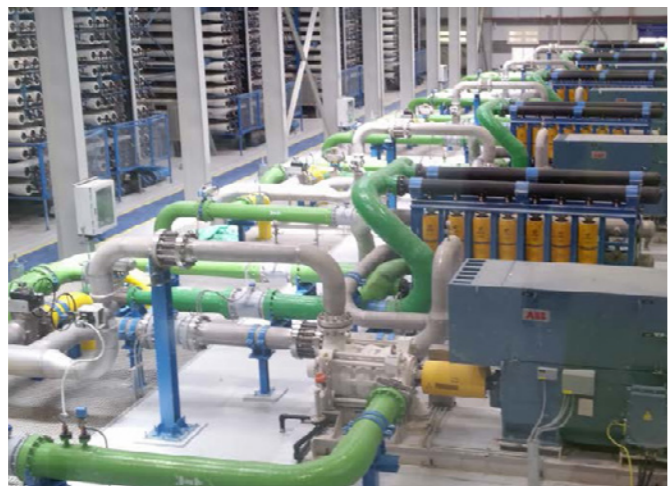
El Alamein desalination plant. Egypt.
