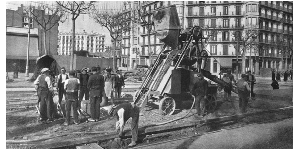
Street paving works on Calle Las Cortes. Barcelona.
