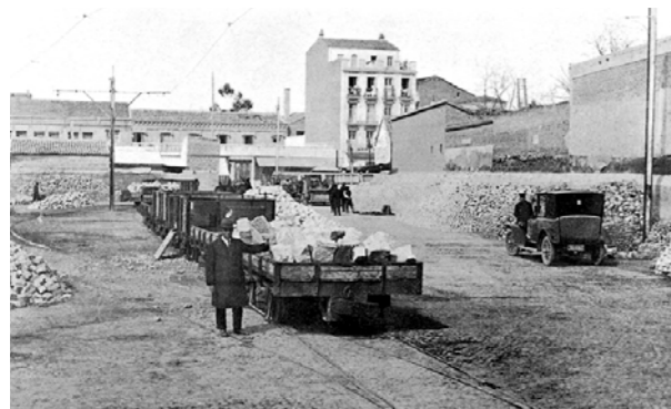
Cuatro Caminos metro station. Madrid.
