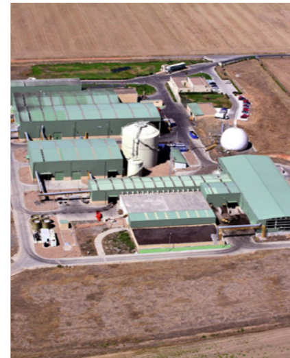
Gomecello plant. Salamanca.
