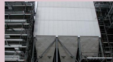
Trockene Abgasreinigung mit Reaktor, Gewebefilter und Entstickung.
